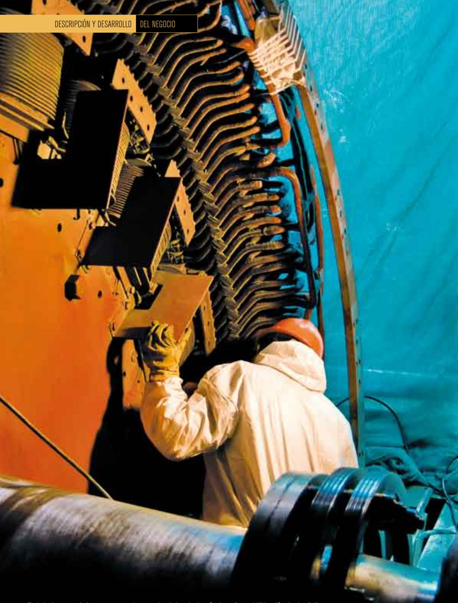
Trabajo de mantenimiento mayor en el generador de la sala de máquinas, Central Hidroeléctrica los Quilos.
